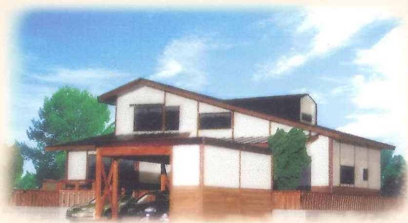
日射取得を大きくするため、南面の窓はあえてLOW-Eガラスを不採用。内部に設けられた土間でも蓄熱効果を求める、地域の特性を活かした「いわきスタイル」の住宅。
