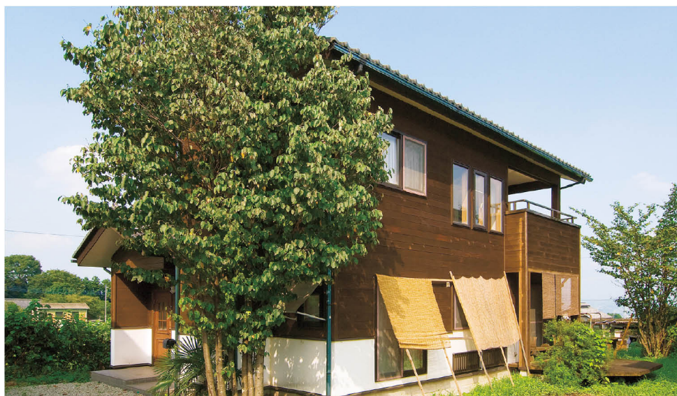
モデルハウス外観。南面のよしずや西の植栽は夏の日射対策。木の下や葉っぱの裏側でどのくらい気温が下がるのか、温度分布の実験も兼ねている
